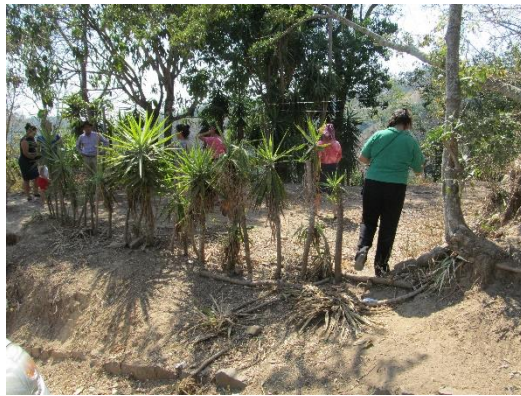
Cantón Casa de Piedra, zona de instalación de Tanque
